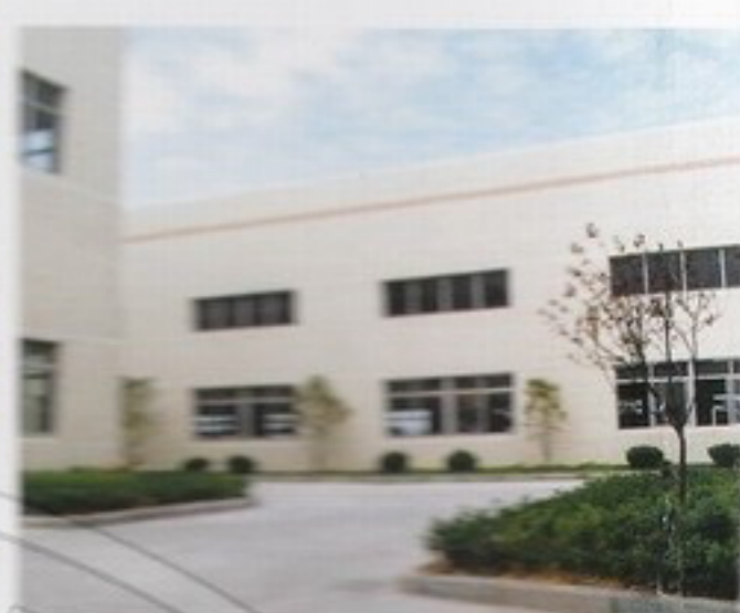
生产车间 / Production workshop
